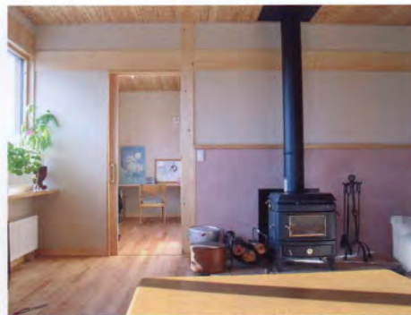
有害物質吸着機能を兼ねたストーブ背面の 壁タイル 奥は寝室
