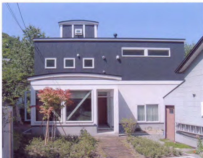
道路側外観 一階左手は事務所 三層目は小屋裏部屋
