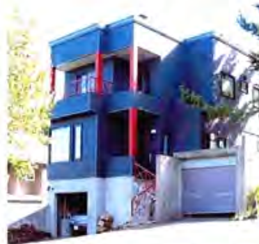
外壁の張替え、収納等のご相談を頂いた円山西町の住宅
