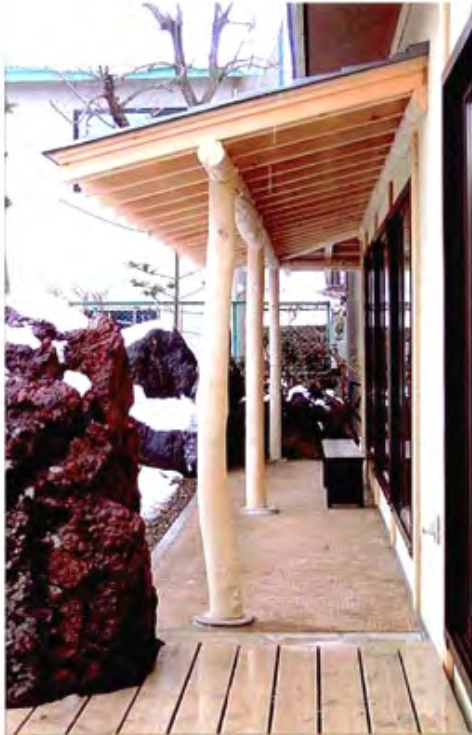
濡れ縁と既存の巨石 奥には「まさ土」のタタキが続く
