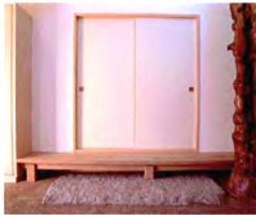
端材を利用した玄関靴脱ぎ石
