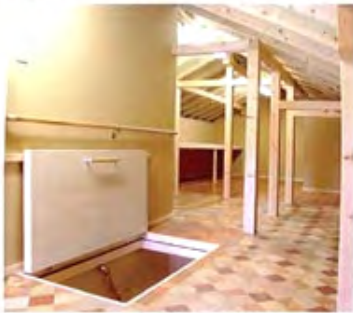
小屋裏として残された2階床
