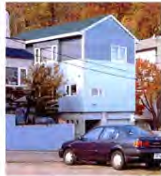
外壁の張替え、断熱補強、屋根の無落雪化、サッシの取り付けなどのご相談を頂いた円山西町の住宅
