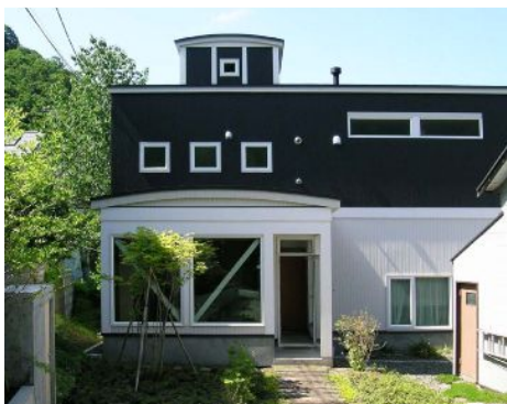
無落雪屋根は北海道の切り札 まだまだデザインの可能性は広い
