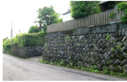
明治生まれの父が自分の手で積んだと自慢していた石垣
