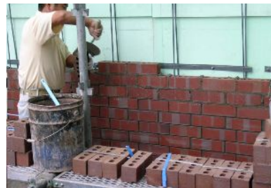
江別といえば日本一のレンガの生産地です レンガを使った断熱改修工事を行う職人さん
